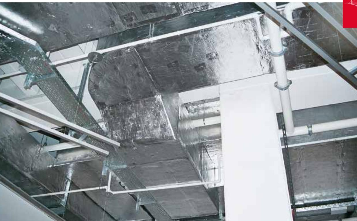
Nichtbrennbare druckfeste Steinwolle-Brandschutzplatte, die einseitig mit einer gitternetzverstärkten Aluminiumfolie kaschiert ist. Die Conlit Ductrock 90 ist mit granuliertem Magnesiumhydroxid durchsetzt, das die Eigenschaft hat, unter Hitzeeinwirkung (wie z. B. im Brandfall) kristallin gebundenes Wasser freizusetzen. Die Conlit Ductrock 90 wird für die Brandschutzbekleidung von eckigen Lüftungskanälen verwendet.
