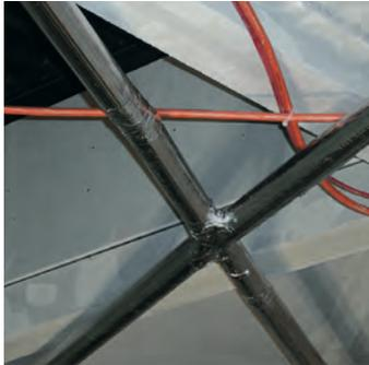
■ Neue Dimensionen für die Bekleidung von Rohrhängern im Conlit Sprinklersystem
