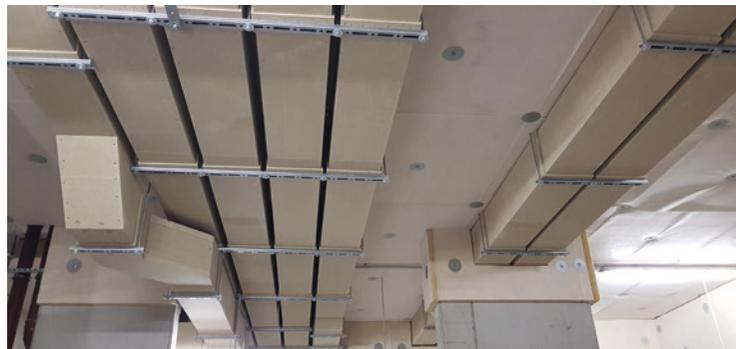
Thermax Lüftungsplatten an der Decke montiert
