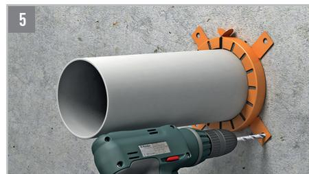
Die passende Brandschutzmanschette muss ausgewählt werden. Bei Rohrdurchführungen durch Decken muss an der Deckenunterseite und bei Rohrdurchführungen durch Wände muss auf jeder Wandseite je eine Rohrmanchette angeordnet werden
